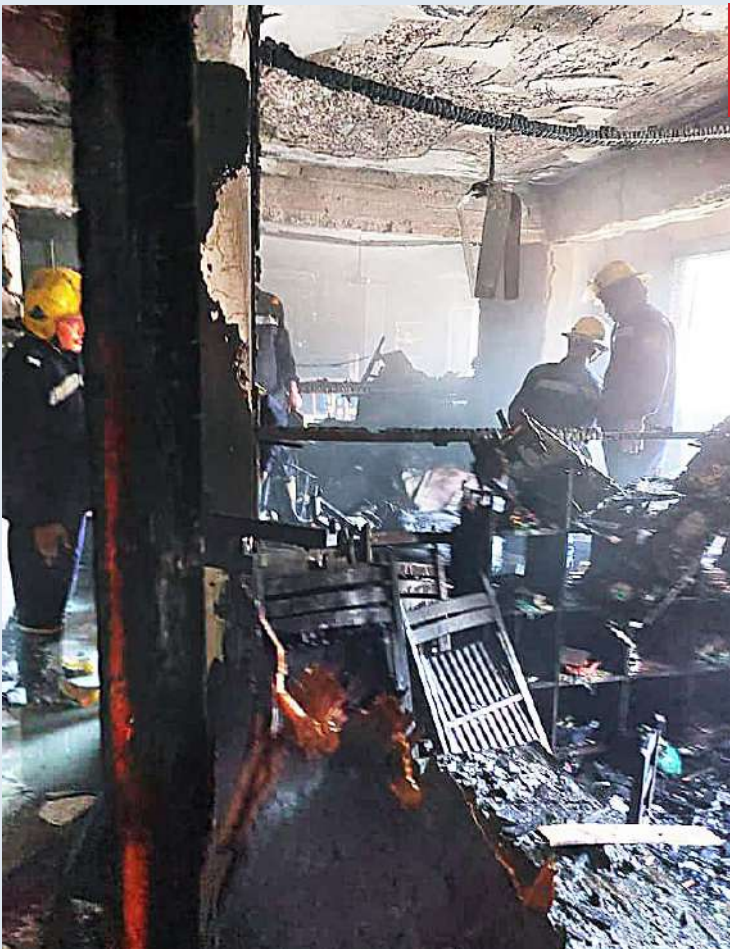
آثار الحريق داخل الكنيسة
